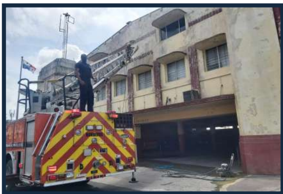
La empresa contratista y personal de la institución iniciaron los trabajos de limpieza y pintura de la Estación 2 Luis J. A. Ducret, en la Zona Regional Colón.
